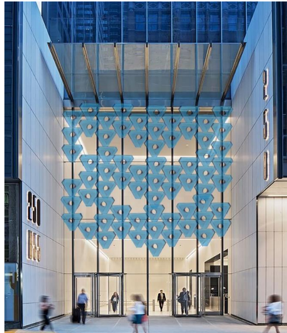
التطبيق في العمارة الخارجية بوحدات مفرغة شفافة زرقاء اللون مستخدماً مسامير التجميع السابق ذكرها مستعينا بهيكل معدني
